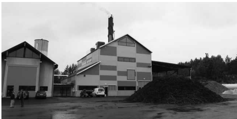
小型のコージェネ地域熱供給プラント。手前は燃料にする樹皮の山
