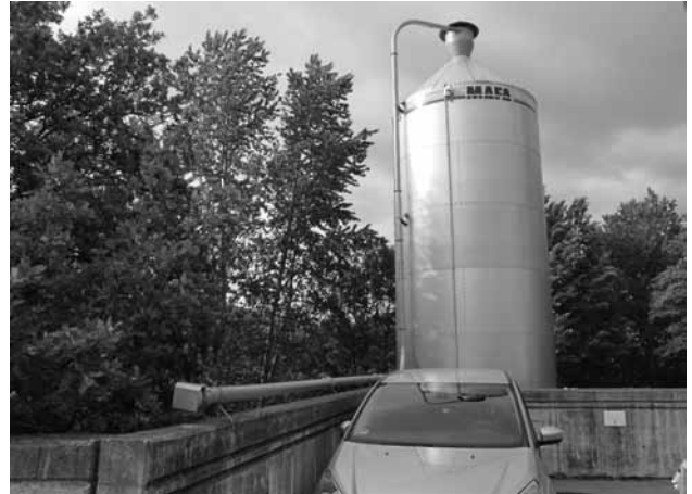
ナッカ市の小規模ペレット熱供給のペレットサイロ
